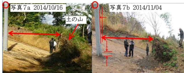
写真赤丸の通信柱のステップを基準に比べると、わずか半月で通信柱はやや抜け上がり、左に傾いていた。また土の山が写真右側、沼の方に動いていた。
